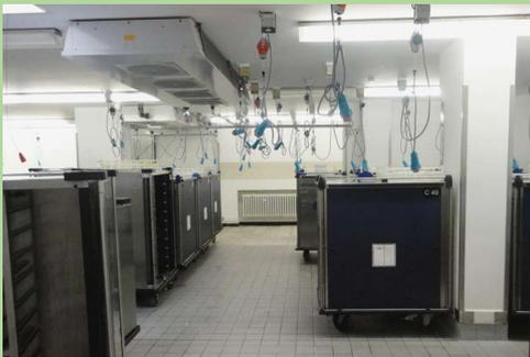
Unser Gerät wird in der Spülstraße des Krankenhauses verwendet. Dort werden im normalen Reinigungsverfahren die Kalt-/Warmhaltewagen mit Desinfektionsmitteln gereinigt.
